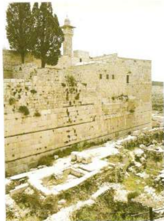
Parte de la obra de sillaría de Herodes en el monte del templo. Los sillares curvados que se ven proyectándose desde la muralla formaba originalmente parte de un puente que salía del área del templo.
